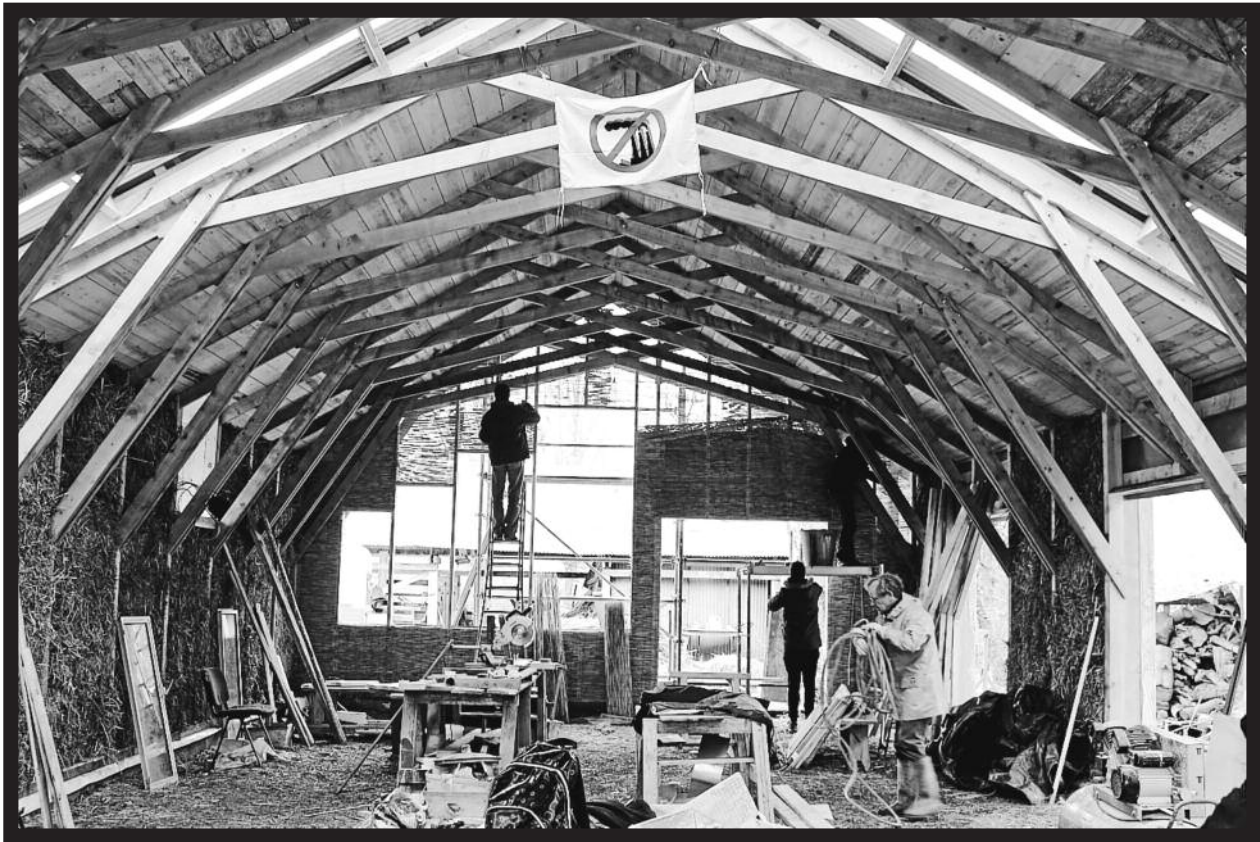
Egunotan, dozenaka euskaldun ari dira bertan obretan, lastozko pareten emokadurak bukatzen eta barneko gelak eratzen. Hartzea LOPEZ ARANA
