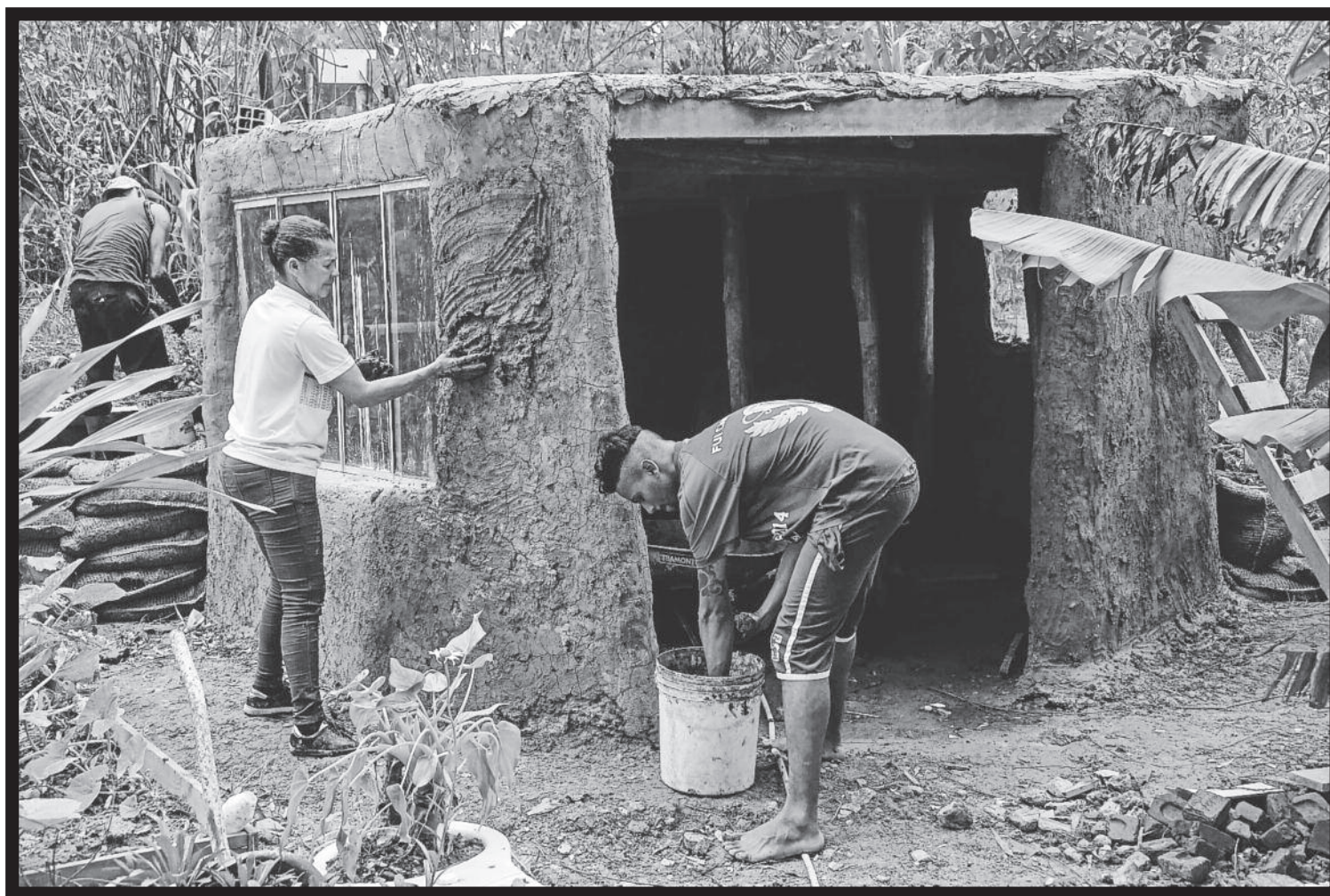
Ludoteka bat eraikitzen ari dira, eskura dituzten baliabideekin. Lia de Souza-k berak hartzen du lokatza, buztina eta porlana nahastuta sortzen duten masa, zentroaren pareta izango denaren aurka botatzeko.
