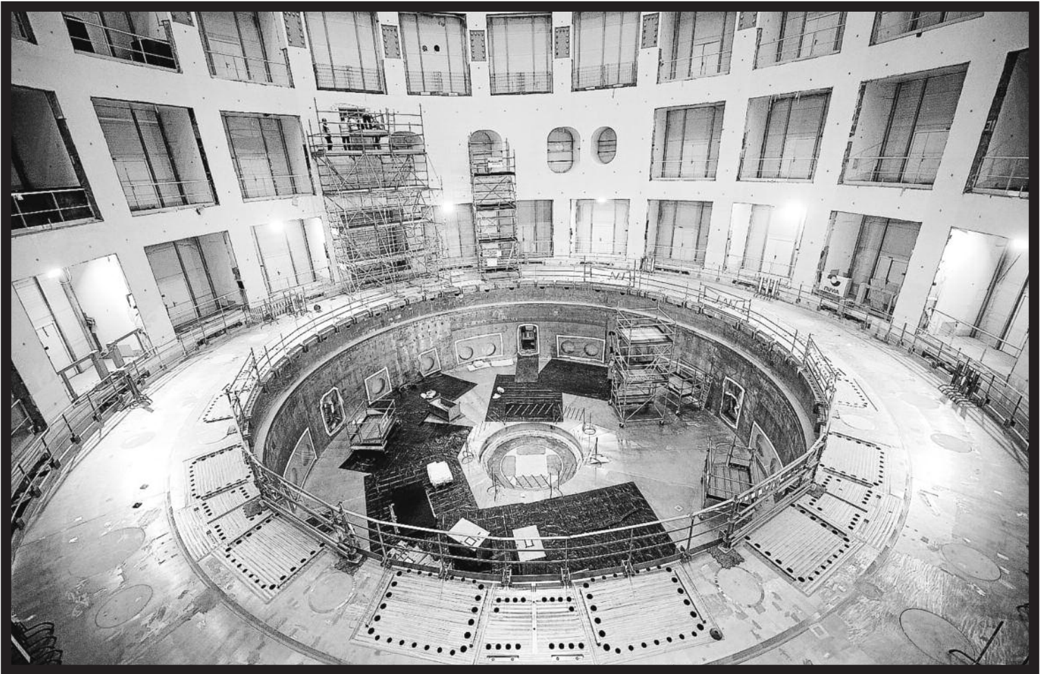
Munduko makina konplexuena den ITER instalazioaren irudia. GAUR8
