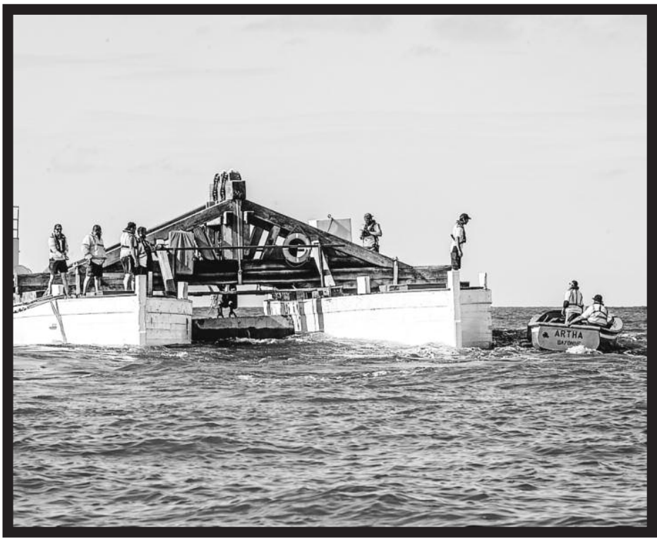
Goian, «Babeslea» itsasontzia hormigoizko kubo daramaten gabarretatik tiraka, Zokoko portutik ateratzen. Behean, blokea bi gabarren artean, jada portutik kanpo. Isabelle MIQUELESTORENA
