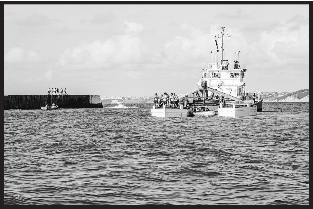
Langileak, Donibane Lohizuneko badia erdiguneko Arthako dikean; ondoan, «Babeslea» itsasontzia ikus daiteke, eta, atzean, hormigoizko blokea daramaten bi gabarrak. Isabelle MIQUELESTORENA
