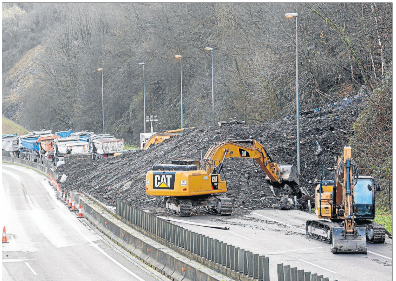
Labores de limpieza en la AP-8, que se abrió parcialmente pese a que todavía persistía el riesgo de nuevos desprendimientos.
