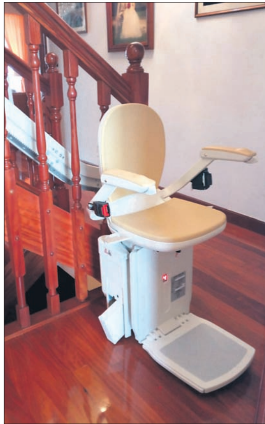
Dos de las instalaciones efectuadas por Bidea: silla salvaescalera y plataforma vertical.
