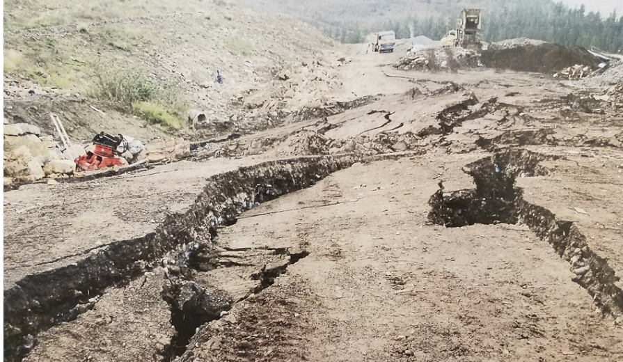
Grandes grietas ubicadas justo por encima de la zona de búsqueda preferente
