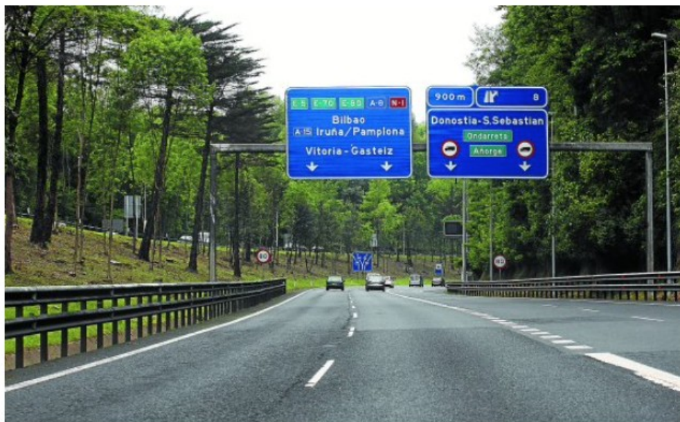
La variante donostiarra, oficialmente Gi-20, soporta la mitad de tráfico desde que entró en servicio el Segundo Cinturón en 2010.
