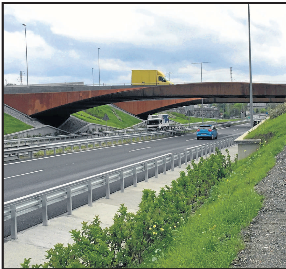
La rotonda elevada sobre la N-I está compuesta por dos puentes de acero Corten de 45 metros. J.S.
