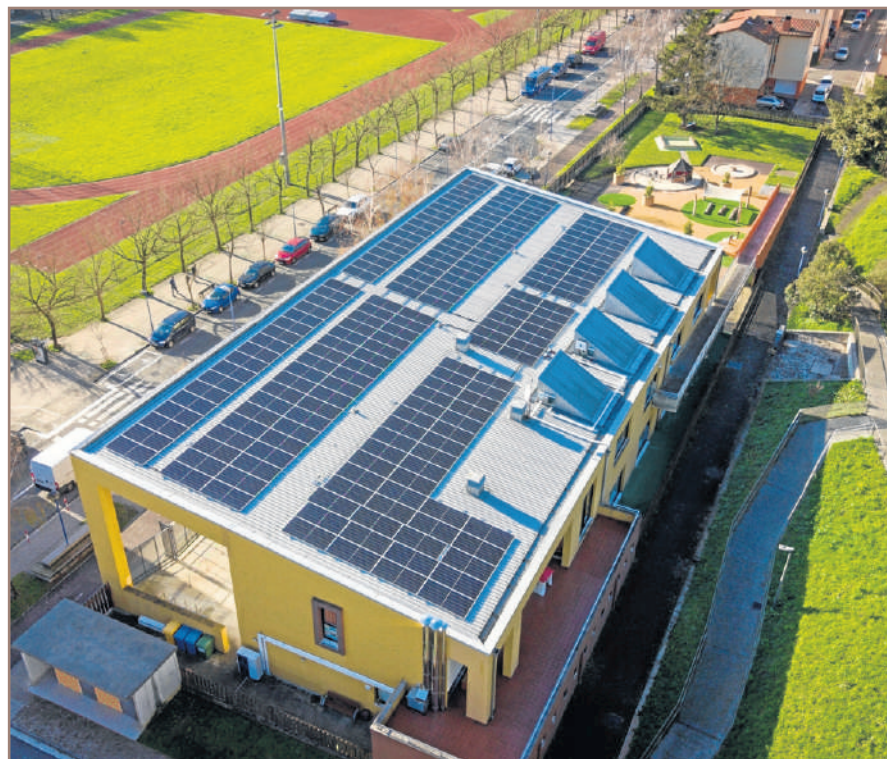
Haur eskolako plaka fotovoltaikoak. ENHERKOM
